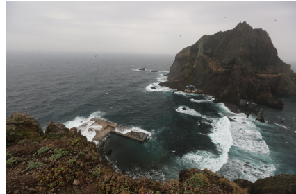
〈사진 1〉 독도 동도 접안부두 모습 (2018.5.23) 〈사진 2〉 독도 동도 접안부두의 월파(2016.3.6)
